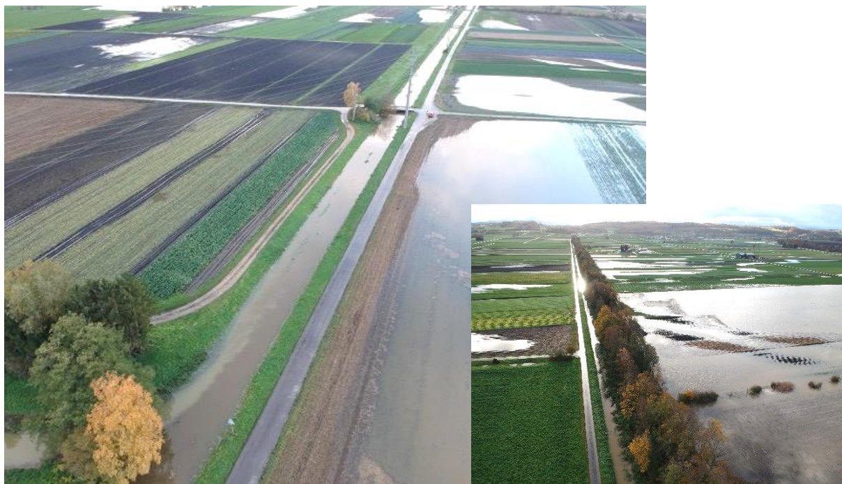
Abb. 1: Aufnahmen Hochwasser Nov. 2023 im Grossen Moos
